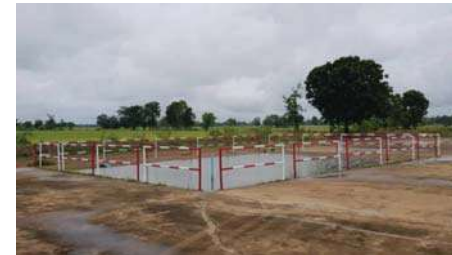
รูปที่ 4.7 บ่อคอนกรีตเก็บน้ำปนเปื้อนน้ำมันและสารเคมี
